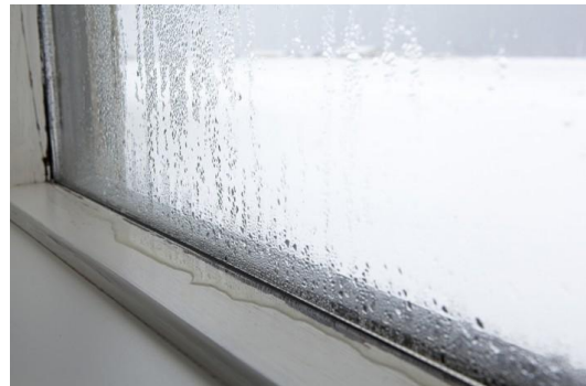
Figura 9 i 10: termografia i condensació d'aigua per contrast tèrmic
